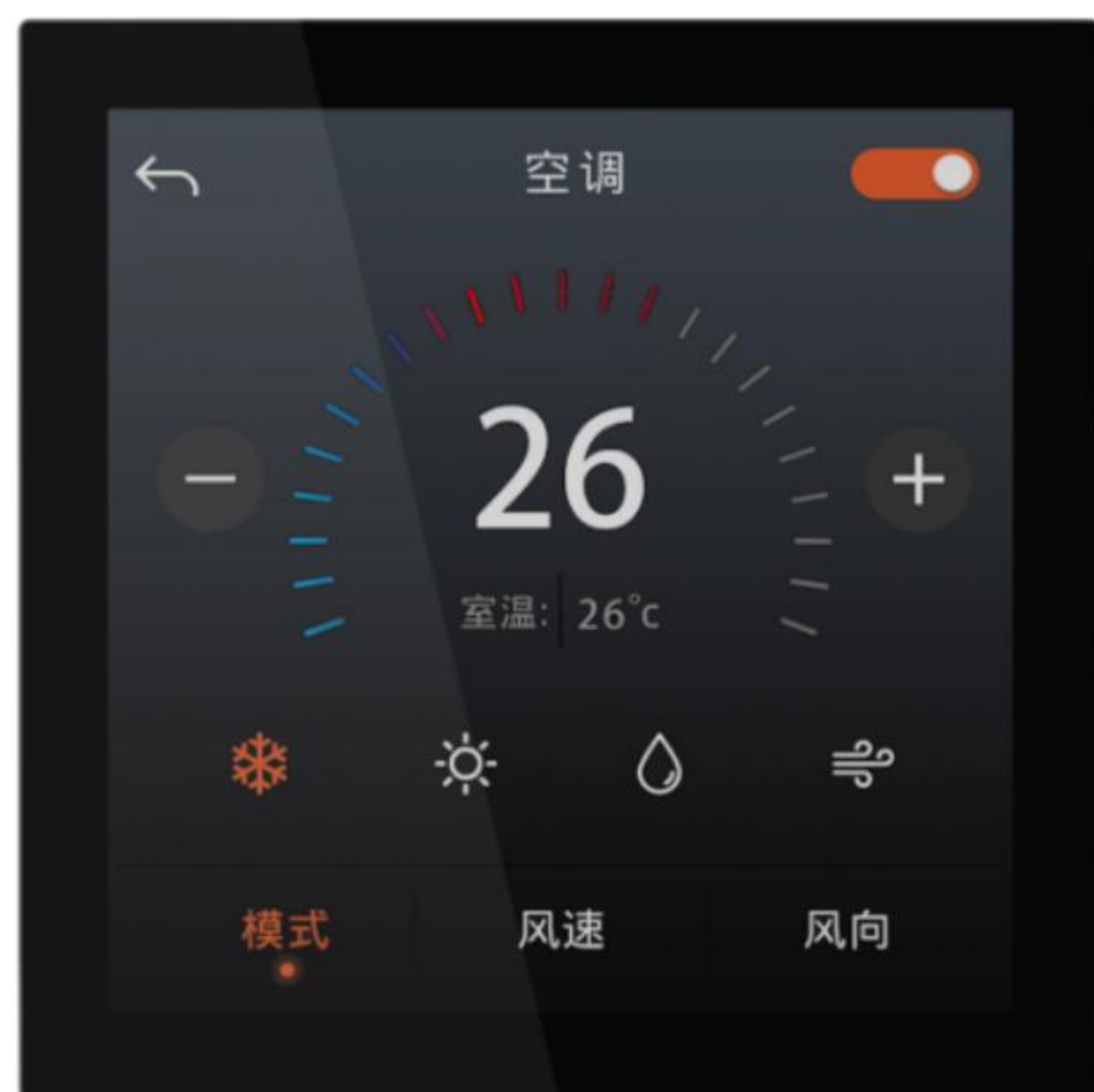
中央空调控制
