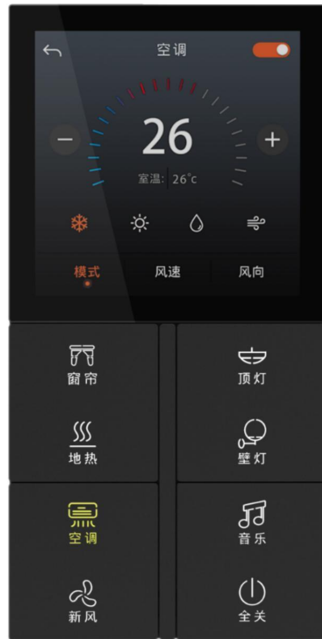
中央空调控制
